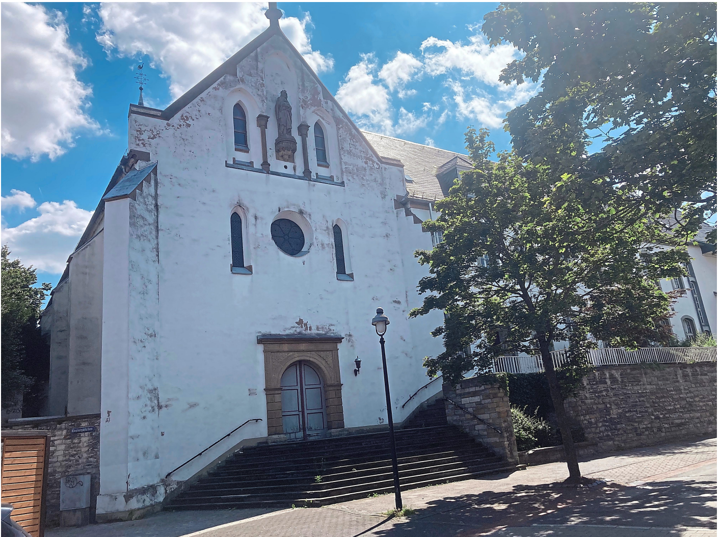
Bröckelnder Putz und verdrecktes Gemäuer: Der Leerstand setzt dem Kloster zu.
